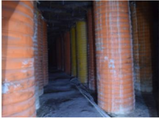
图 3-8 泵送支柱支撑空巷
