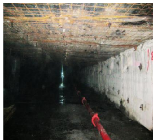
图 3-6 柔模混凝土巷旁充填沿空留巷
