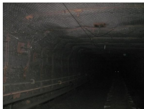
图 3-2 注浆加固后治理情况
