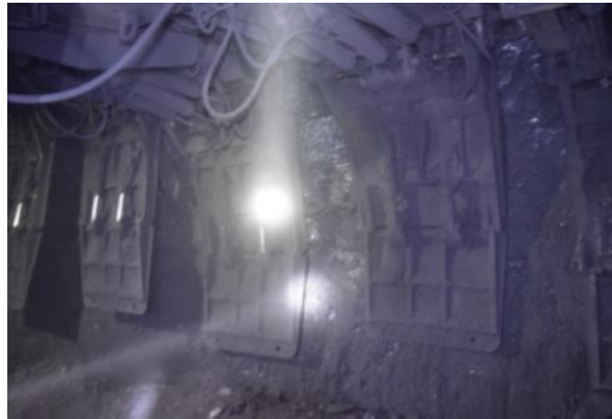
图 3-4 大采高工作面深孔预注浆防治煤壁片帮
