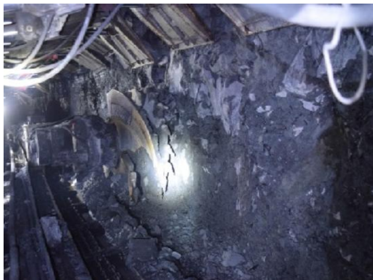
图 3-10 残采区注浆加固
