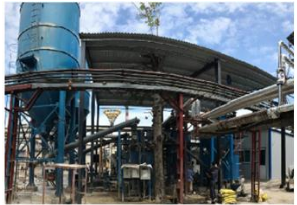
图 3-11 超高水材料充填站
