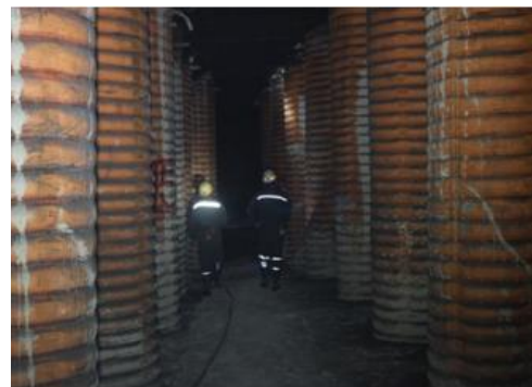
图5 充填支柱现场施工情况
